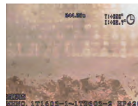
TVカメラ調査 (経年12年) 熱硬化
