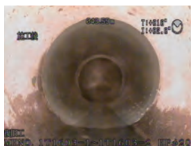
切り取り後の復旧施工
