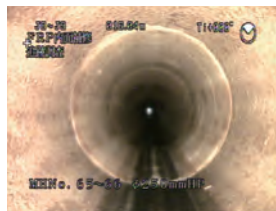
TVカメラ調査 (経年14年) 光硬化
