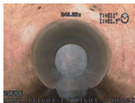
TVカメラ調査 (経年12年) 熱硬化
