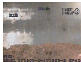
切り取り後の復旧施工
