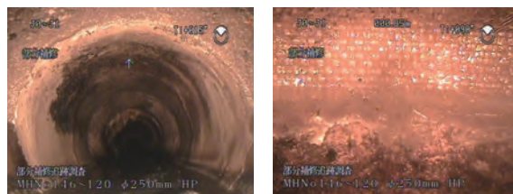
TVカメラ調査 (経年6年) 熱硬化
