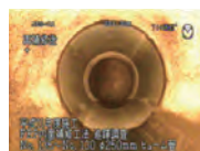
切り取り後の復旧施工
