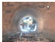
切り取り施工
