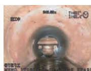
切り取り施工
