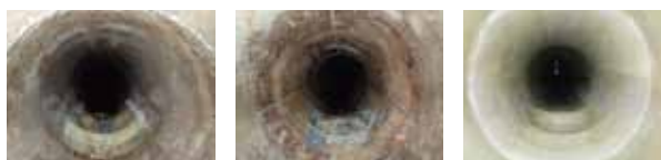
切り取り前 切り取り後 切り取り後の復旧施工
