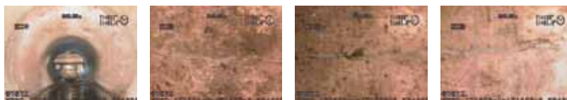
切り取り施工 切り取り後 (クラック部に樹脂注入) 切り取り後 (クラック部に樹脂注入) 切り取り後 (クラック部に樹脂注入)
