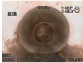
切り取り後の復旧施工
