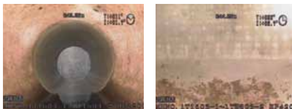
TVカメラ調査(経年12年) 熱硬化
