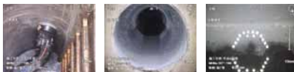
切り取り後の復旧施工状況 切り取り後の復旧施工 切り取り後(端部の状態)
