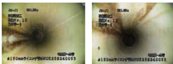
(内面) 異常なし (内面) 異常なし
