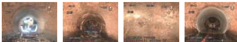
切り取り施工
