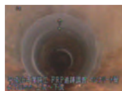
φ250 (HP) 補修箇所(本管部) 熱硬化 経年4年
