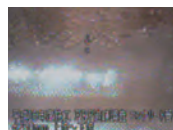
φ250 (HP) 補修箇所(本管部) 熱硬化 経年4年
