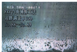
4. φ350 (HP) 補修箇所(クラック B、浸入水 B)、熱硬化
