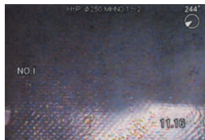
4. φ350 (HP) 補修箇所(クラック B、浸入水 B)、熱硬化
