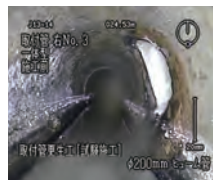
一体型施工前
