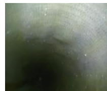
取付管ライニング後の Zパイプ管内面
