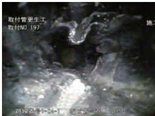
施工前状況 取付管 管頂部・管底部 瀝青積層材の膨張 確認
