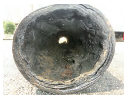
管断面はタマゴ型になっていた
