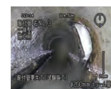
一体型施工前
