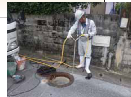
2. ノズルを差し込み注入
