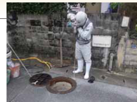
1. 注入孔の削孔
