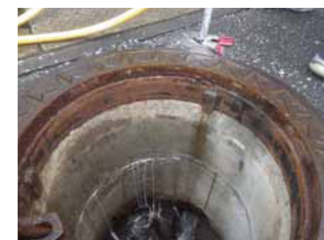
3. 止水剤流出確認
