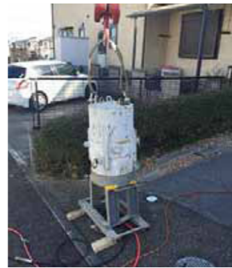
ウエイト(700kg)を用いた施工方法
