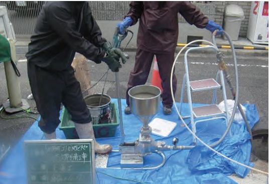
注入量確認測定、エア抜き設置
