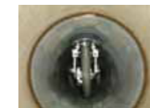
注入口へセッティング
