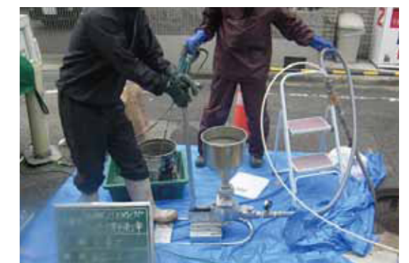
モルタル充填工
