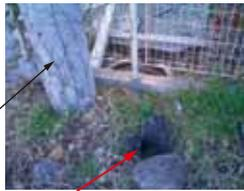
隣家境界内の電柱根元に陥没穴
