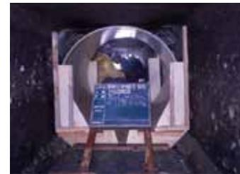
φ1000ポイド管を利用して型枠作成
