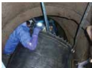
施工機組み立て中
