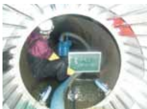
水替え工 6インチポンプ
