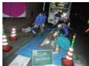
補修材含浸状況
