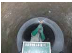
取付管管口削孔状況
