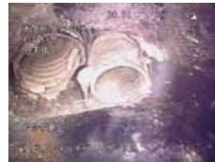
取付管ライニング 施工後
