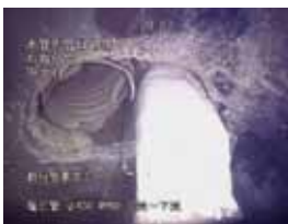
取付管ライニング 施工中
