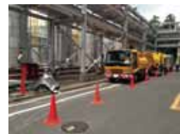
現場全景 (プラント配管下の狭い箇所)
