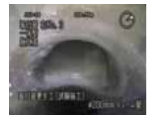
取付管ライニングと 部分補修(一体型)の 接合部分の仕上がり
