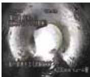
ライニング工 (光硬化中)
