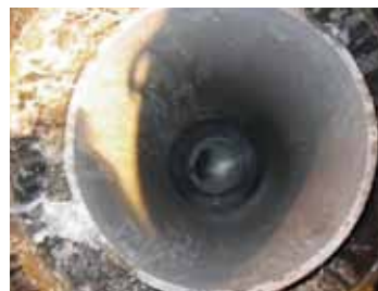
塩ビ製底部有孔ますからの施工後
