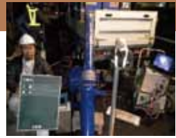
取付管ライニング施工中
