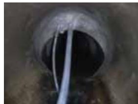
① 空洞に粘土モルタルを充填
