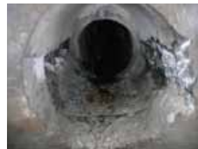
② 管きょ底部をはつり、管底部を既設管と合わせる副管を無収縮モルタルにて埋め殺し
