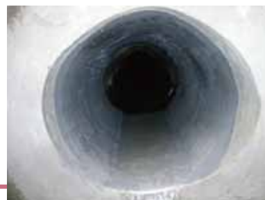
② 管きょ底部をはつり、管底部を既設管と合わせる副管を無収縮モルタルにて埋め殺し
