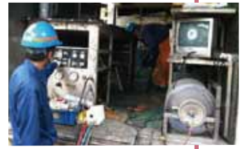
工事車側にて、施工機に 内蔵されたカメラ映像を 見ながら位置合わせを 行い、拡径・硬化させる
