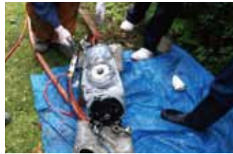
伸縮一体型に補修材を巻き付け、 収縮させる
