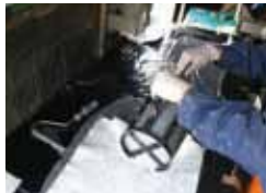
200-150の補強繊維に 樹脂を含浸
