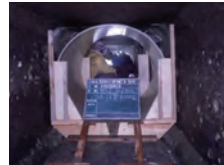
φ1000ボイド管を利用して 型枠作成
