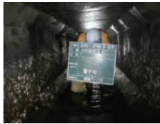
施工前（干潮時）
