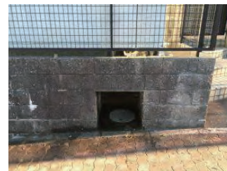
ます（深さ 0.9m） 補修施工後
