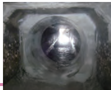
φ1000ボイド管を利用して 型枠作成
