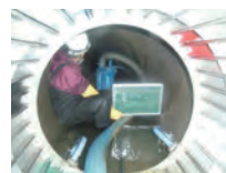
水替え工 6インチポンプ
