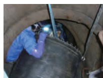
施工機組み立て中
