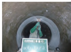
取付管管口削孔状況
