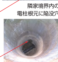
ます深さ: 2.30m 底部より35cmのところに穴
