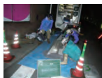
補修材含浸状況
