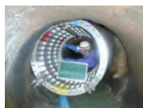
施工機組み立て完了
