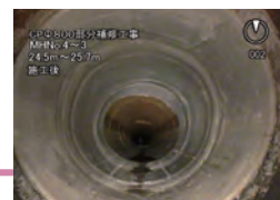
巻き付け完了→施工位置に移動させて補修を行う
