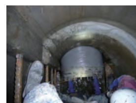
施工機の挿入状況 （水量はインバートいっぱいまであり）
