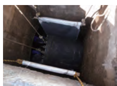
材料を垂らして、施工機を移動
