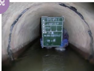
人孔より26m地点の施工前
