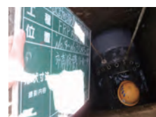
巻き付け完了→施工位置に移動させて補修を行う
