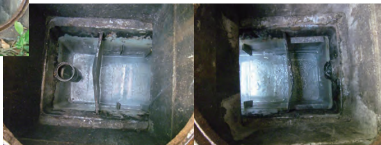
施工完了後の写真
