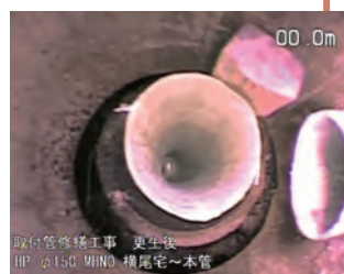
更生後、モルタル注入前の状況
