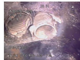
取付管ライニング 施工後
