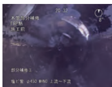
部分補修 施工前
