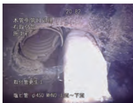
取付管ライニング 施工中
