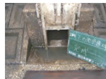
樋管口 ゲート
