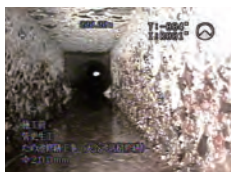
角管部 施工前
