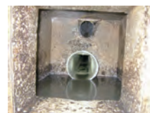
樋管口 ゲート内
