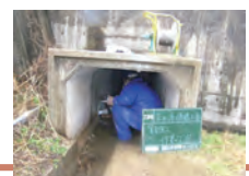
到達側 施工状況
