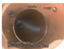
施工前(取付管内)
