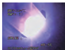
副管の施工中 (光硬化)
