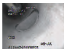
副管の更生後 (副管口 250-150)
