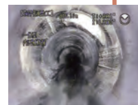
一体型施工後
