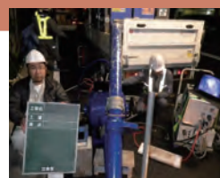
取付ライニング施工中
