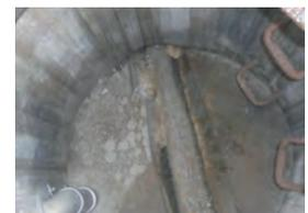
**対策** 下流管口部分に塩ビ管を延長設置するため、部分補修にて固定する。
