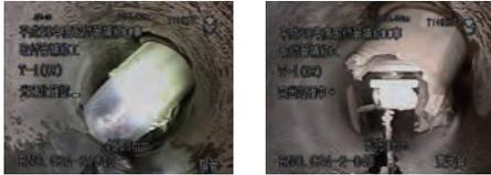
φ250 取付管ライニング施工 ライニング材切削工
