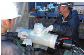
① 補修材巻きつけ状況
