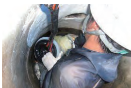
① 補修材巻きつけ状況
