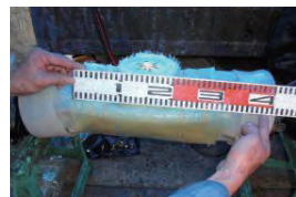
② 補修材 張り幅30cm
