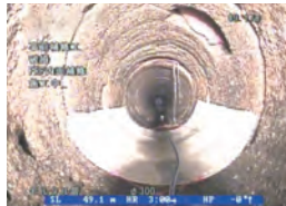
半割れ管の挿入
