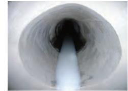
③ 管きよ型の型枠をはめ込み、無収縮モルタルにて管形成
