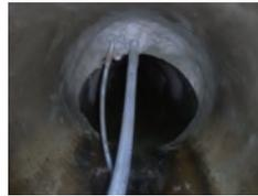
① 空洞に粘土モルタルを充填
