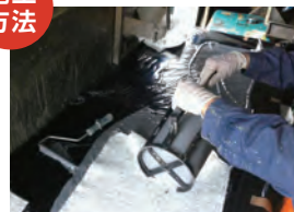
200-150の補強繊維に 樹脂を含浸
