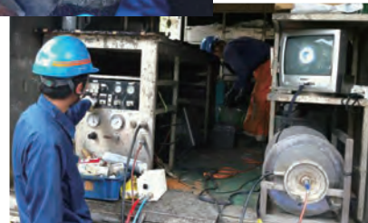
工事車側にて、施工機に内蔵されたカメラ映像を 見ながら位置合わせを行い、拡張・硬化させる
