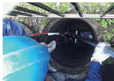
φ450人孔より、 T字棒を使って 施工機を挿入
