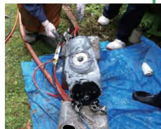
伸縮一体型に補修材を巻き付け、 収縮させる
