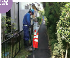
現場状況 洗浄工
