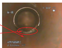
陶管曲管部の底部欠落
