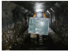
施工前(干潮時)
