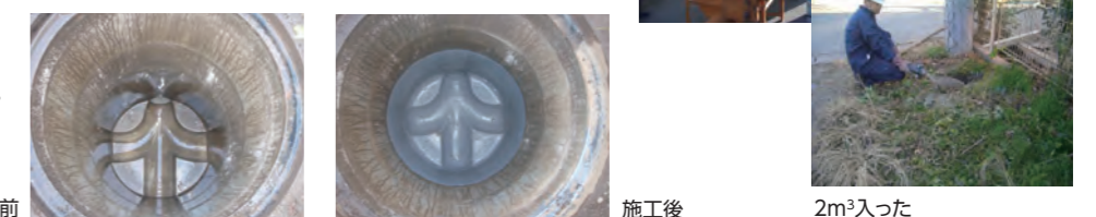
施工前 施工後 2m³入った
