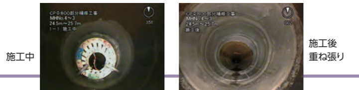
巻き付け完了→施工位置に移動させて補修を行う
