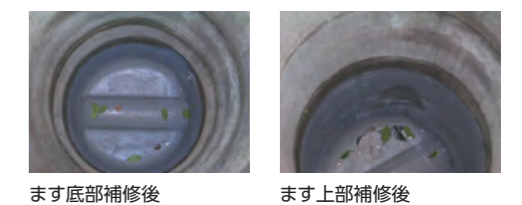
ます底部補修後 ます上部補修後
