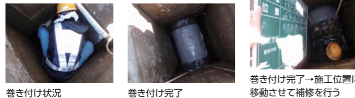
巻き付け完了→施工位置に移動させて補修を行う
