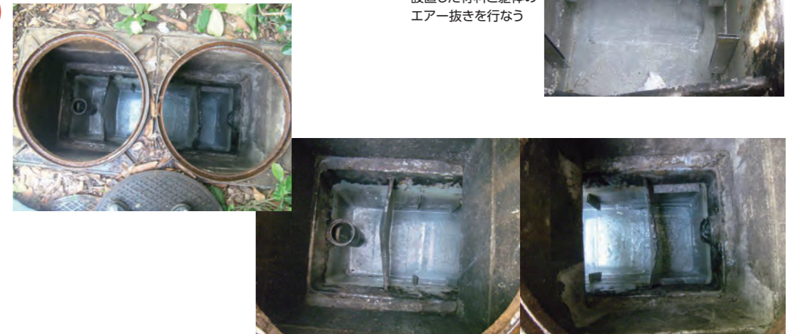
施工完了後の写真
