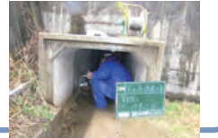
到達側施工状況
