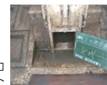
樋管口ゲート
