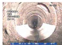
半割れ管の挿入
