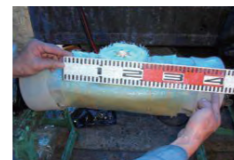
②補修材 張り幅30cm
