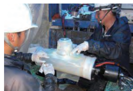
①補修材巻きつけ状況
