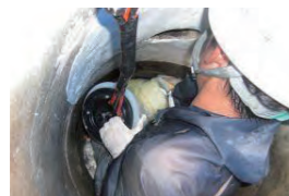
①補修材巻きつけ状況
