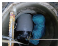
内面補修施工中
