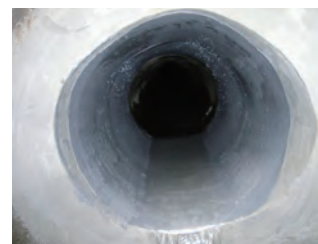
④内面補修を行い、仕上げる
