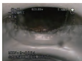
取付管口部分
