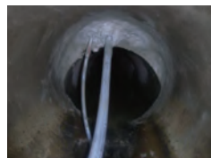
①空洞に粘土モルタルを充填
