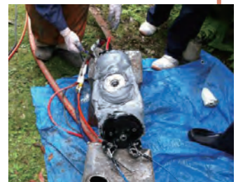
伸縮一体型に補修材を巻き付け、収縮させる
