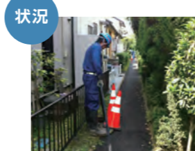
現場状況 洗浄工
