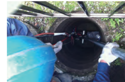
φ450人孔より、T字棒を使って施工機を挿入
