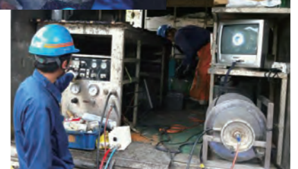
工事車側にて、施工機に内蔵されたカメラ映像を見ながら位置合わせを行い、拡径・硬化させる
