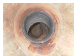
切削した後の補修後
